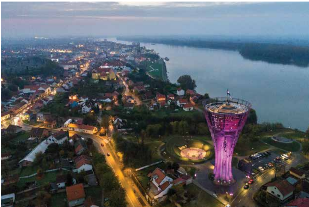
Fotografija iz zraka obnovljenoga vukovarskog vodotornja i grada heroja 2020. godine.
