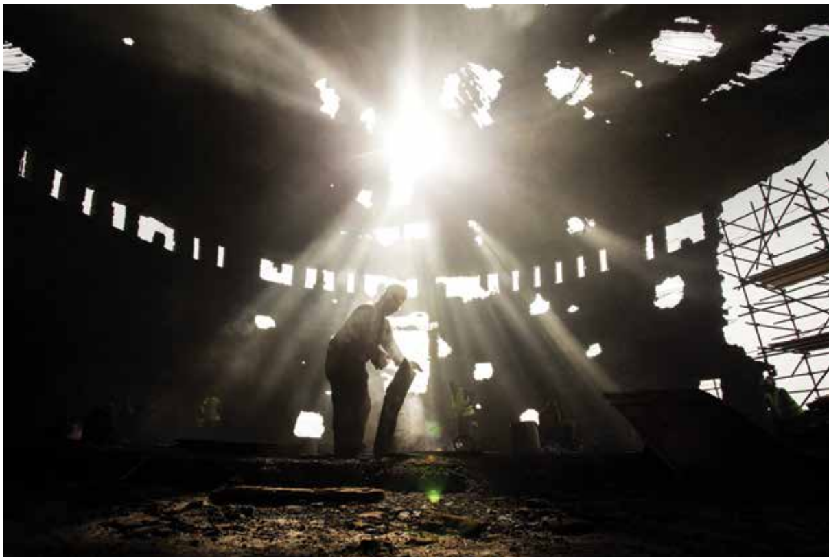
Pogled u utrobu simbola ratnoga Vukovara – vodotornja tijekom njegove obnove 2018. godine.
